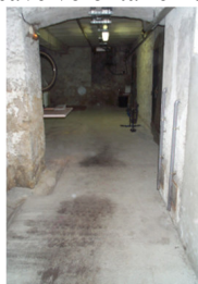
Dallage béton armé du couloir de la cave
