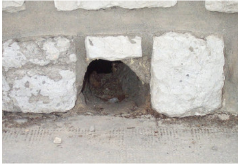
Entrées d'air du vide sanitaire
